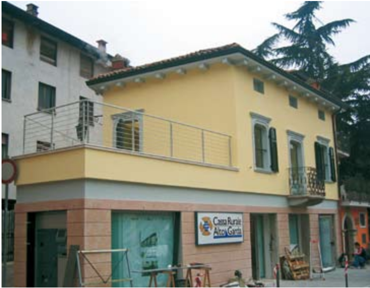
Ultimi lavori a Nago
