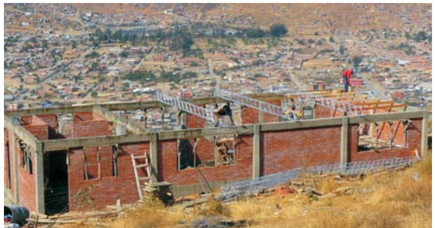
La nuova mensa in fase di costruzione
