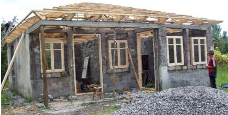
Costruzione di case in Abkhazia (Georgia).
